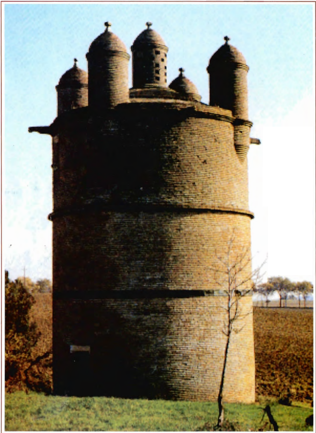
Pigeonnier à poivrières à Cintegabelle
